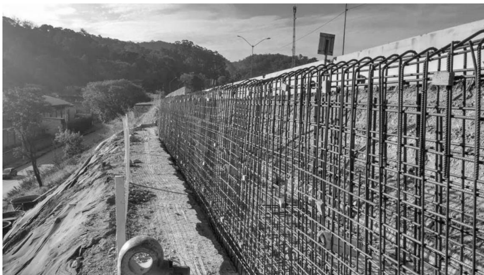
Figura 6 - Armação de cortina moldada in loco
