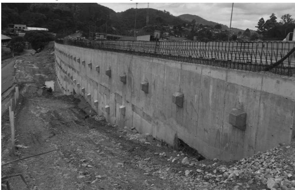
Figura 7 - Concretagem / acabamento da cortina
