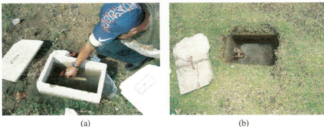
Figura 5.3 – Vazamentos encontrados nas áreas verdes públicas de Campina Grande (Fotos: Maria Isabel Mota Carneiro, 2007).
