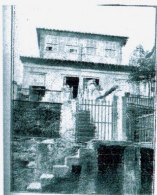
RUA DO PROPÓSITO N.º 10, ANT. 32 Segundo local onde se reuniu a Igreja de São Vicente. Edificação demolida em 1862 e 63-1863. Foi neste edifício fundado o Grupo de São João, 1.º grupo de São Paulo, em 1841-1842, sendo mais tarde pastor da mesma Igreja. (Vila pitagora 26, 127 e 128)
