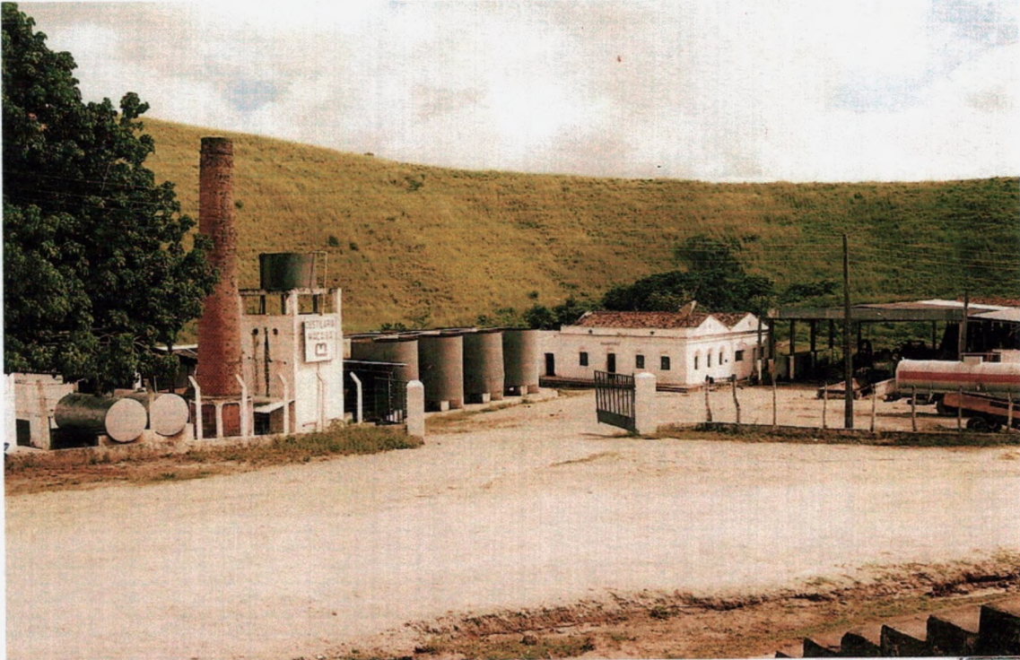
Foto 10. (Engenho Macaíba). Fonte: Railson Serafim.
