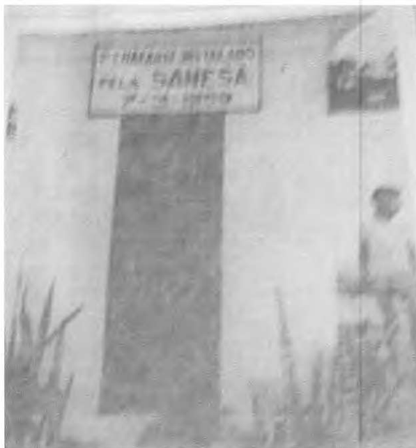
Chafariz construído e inaugurado pela SANESA, no bairro de Bodocongó. 25
