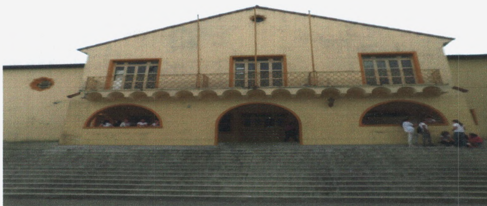
Figura 2 Colégio Estadual da Prata atualmente. Os traços arquitetônicos de sua estrutura inicial continuam mantidos.
