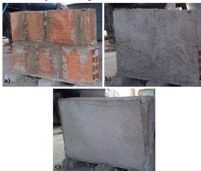
Figura 13- Construção da parede: a) tijolo cerâmico de 8 furos assentado; b) chapisco; c) argamassa de revestimento.
