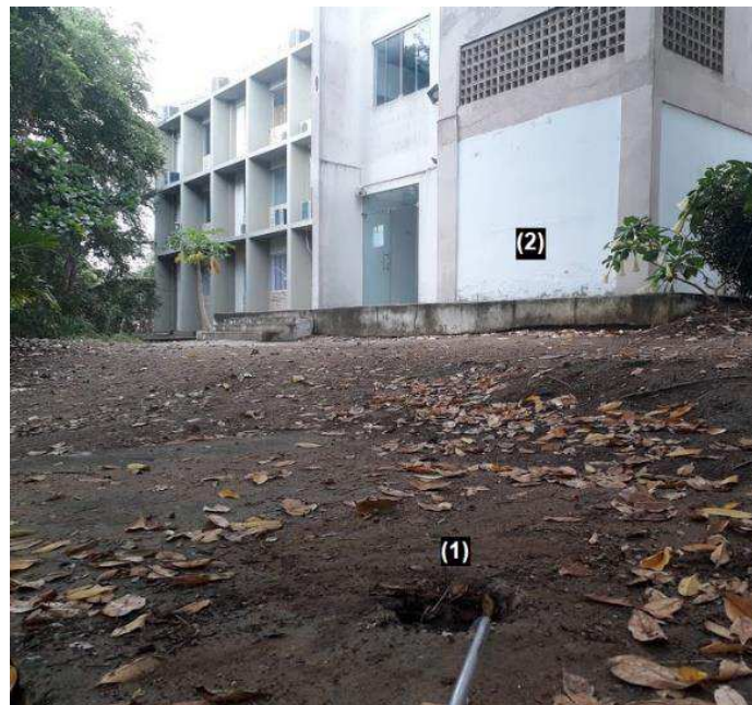
Figura 20 – (1) Ponto de coleta da fossa séptica/UFCG. (2) Prédio em que a fossa fica localizada.
