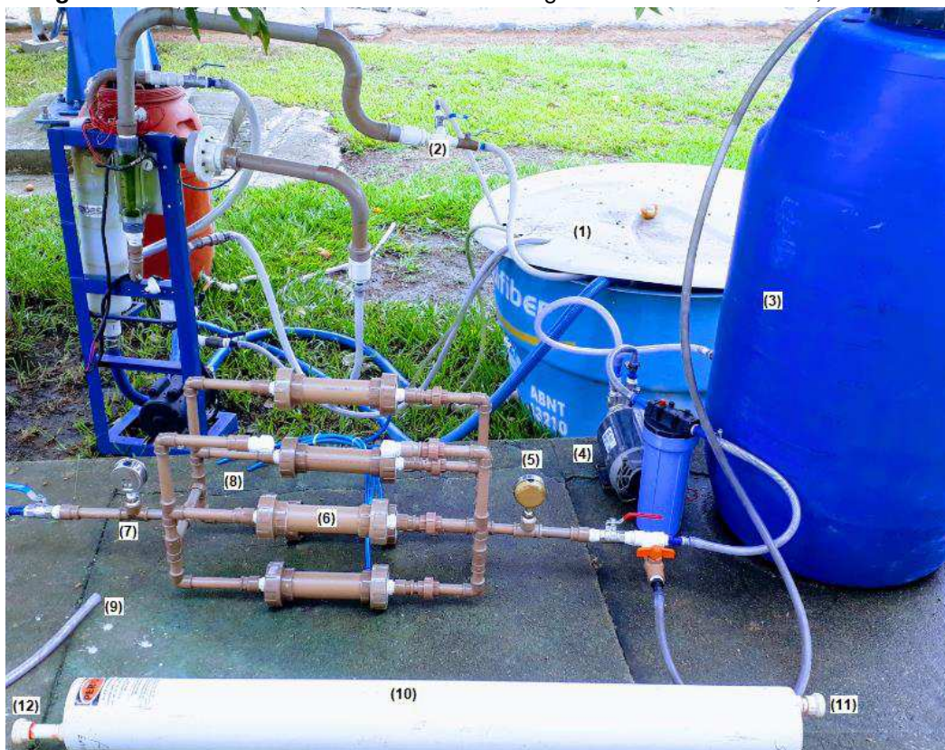
Figura 27 – Sistema híbrido de tratamento de águas residuárias com HC, MC e OI.
