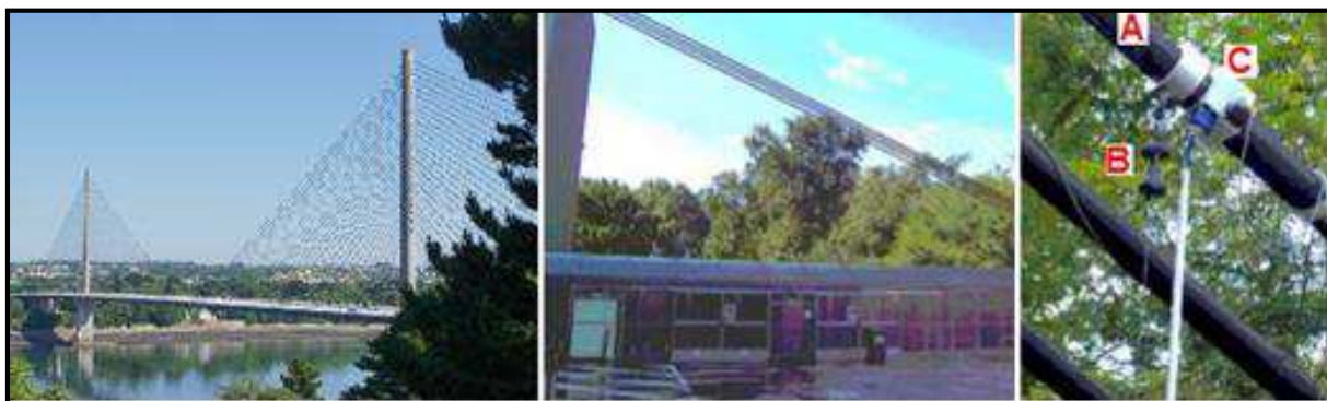
Figura 13 - Ponte Iroise na França. Vista geral dos cabos de aço. (A) Cabos com dispositivo de LMF de NiTi (Fonte: adaptado de Torra et al. 2013)
