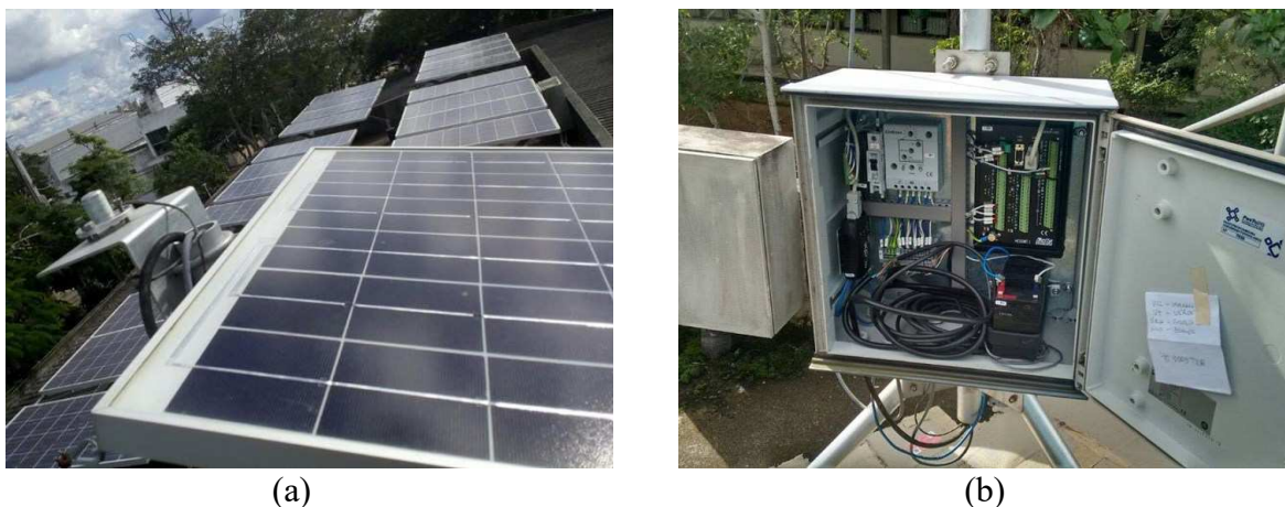
Figura 24 – Sistema de coleta de dados do LEIAM: (a) pirômetro e (b) datalogger .
