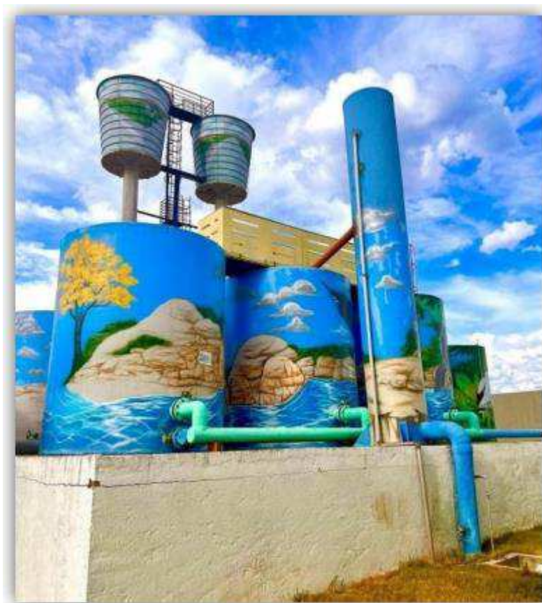
Figura 2.23 – Camara de pressão, responsável pela uniformização da pressão para os filtros.
