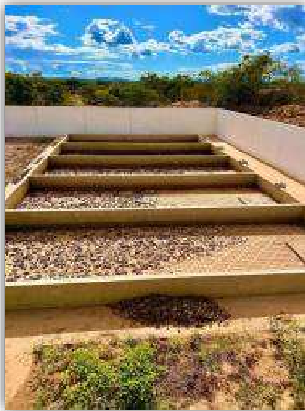
Figura 2.25 – 5 células de leito de secagem, através das quais foi produzido o lodo de ETA.
