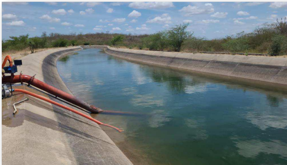
Figura 2.21 – Captação da ETA no canal do sertão em Piranhas (AL).
