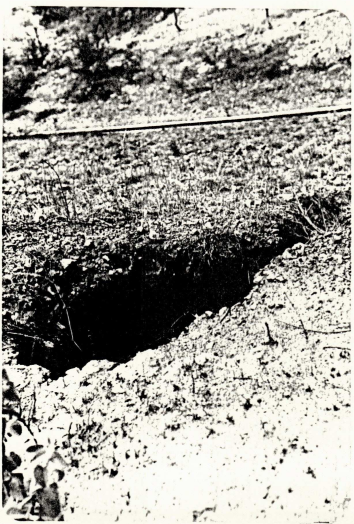
Fotografia - 9 Barragem Bom Jesus (Água Branca- PB), mostrando uma fis- sura transversal, bastante evoluida. A) lado montante B) lado jusante.
