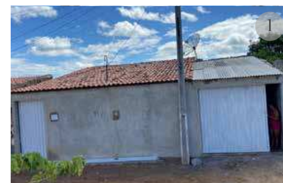
Figura 22 - Calçada Irregular Fonte: SEDU (2023)
