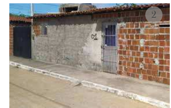
Figura 23 - Calçada Regular Fonte: SEDU (2023)
