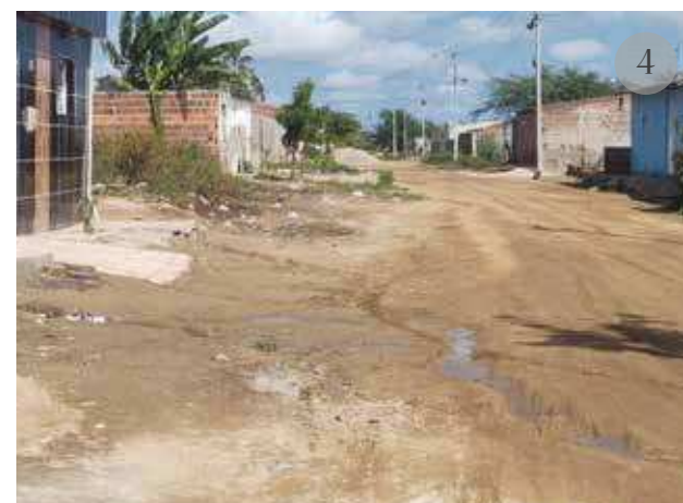
Figura 17 - Esgotamento a céu aberto Fonte: Maria Eugênia Valença (2023)
