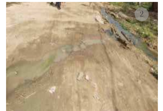
Figura 15 - Esgotamento a céu aberto Fonte: Maria Eugênia Valença (2023)
