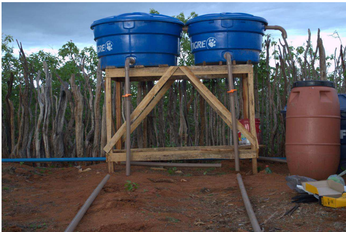
Fonte: autor 2022 – Montagem dos equipamentos para o experimento
