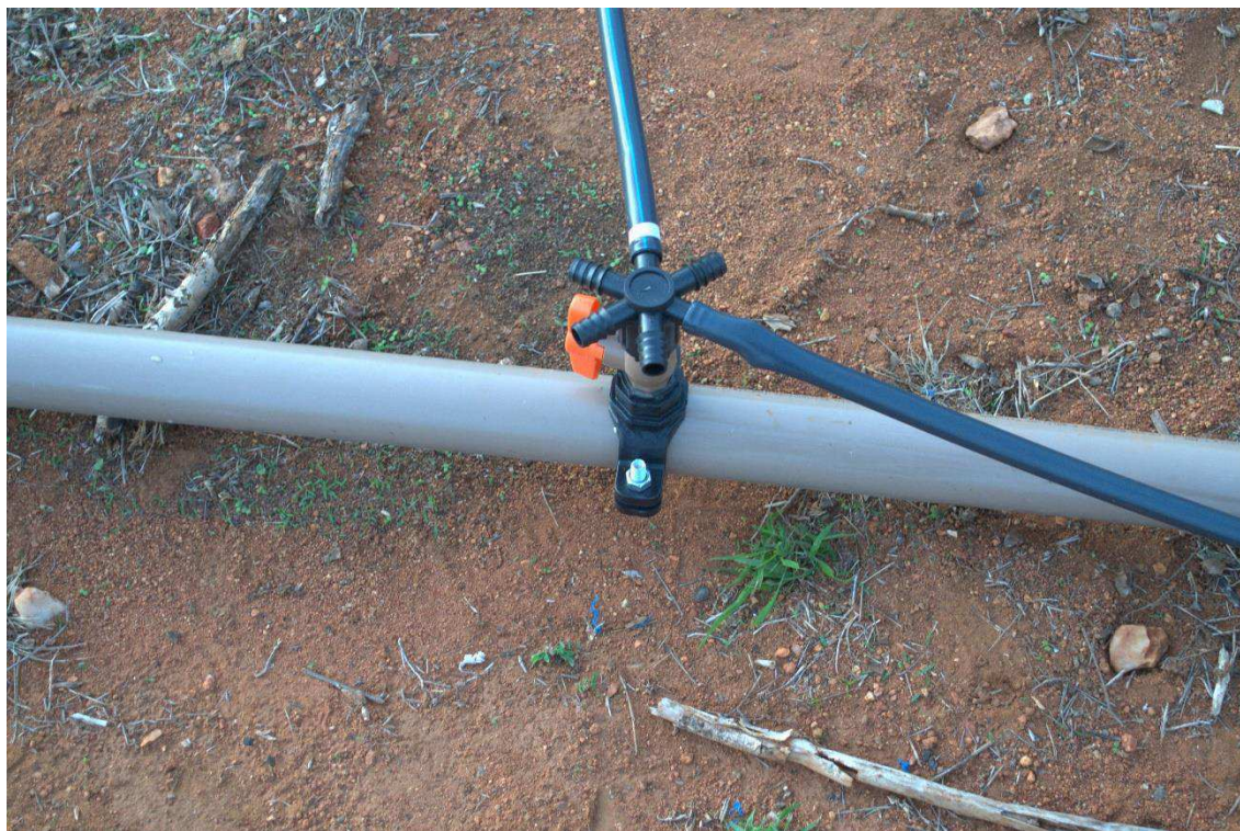
Imagem 2: Sistema de saídas de água para as plantas (aranha)
