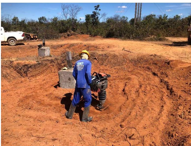
Figura 22 – Reaterro e compactação de solo em uma sapata.
