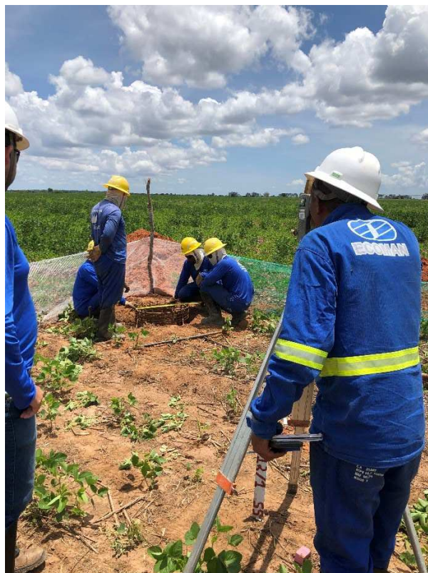
Figura 16 – Nivelamento de tubulão pelo topógrafo.
