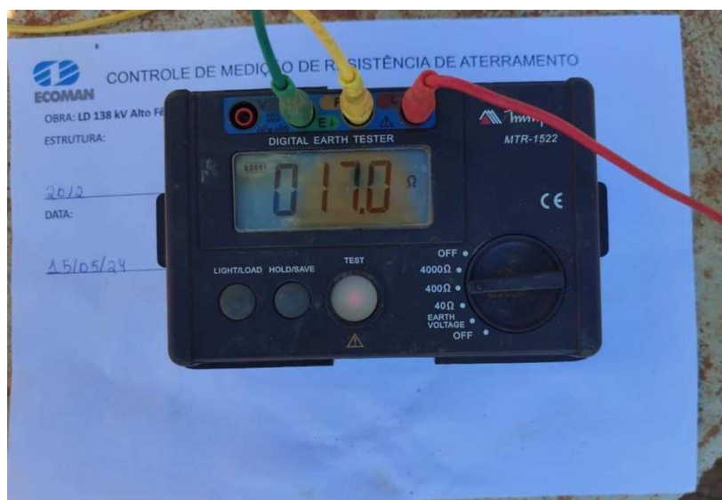
Figura 23 – Medição da resistência de aterramento da estrutura 26/2.
