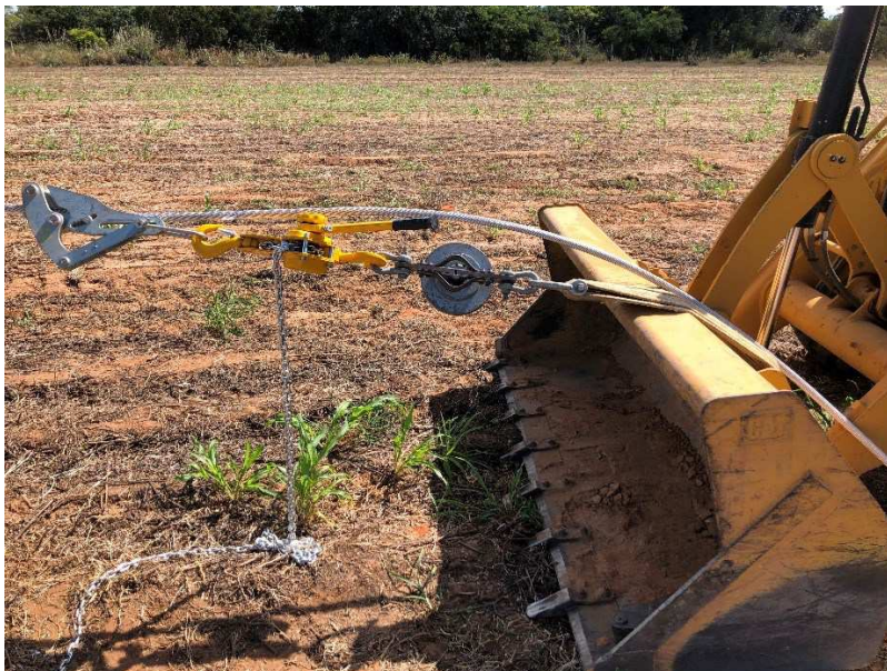
Figura 31 – Dinamômetro acoplado a retroscavadeira para aferição de tração no cabo.
