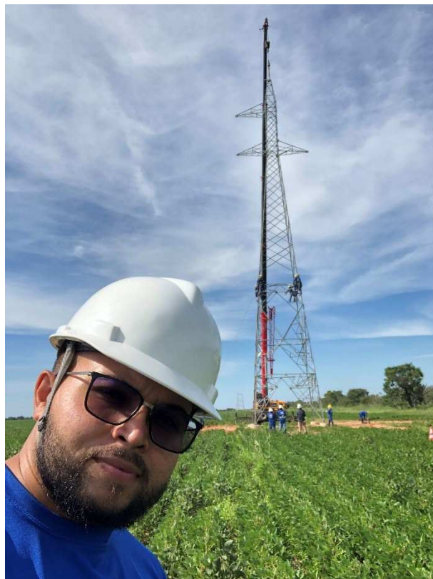
Figura 28 – Acompanhamento de içamento de corpo básico.
