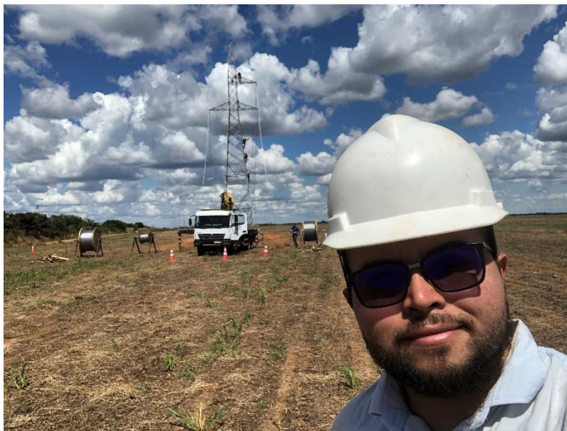
Figura 29 – Acompanhamento de lançamento dos cabos condutores.
