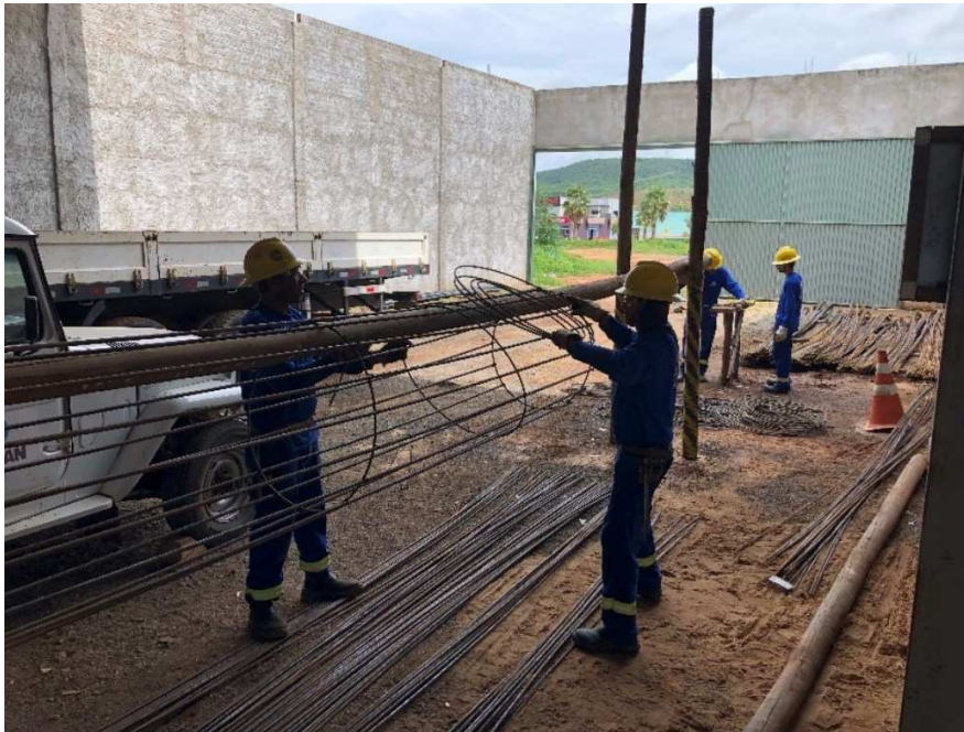
Figura 10 – Início da armação de tubulões.
