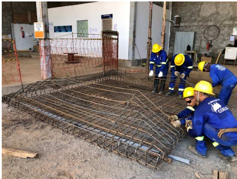
Figura 11 – Processo de armação de sapatas.
