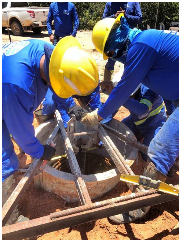
Figura 17 – Preparação e nivelamento de forma e gabarito com stub .
