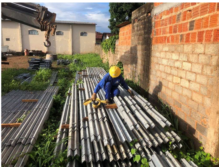
Figura 26 – Processo de carregamento de estrutura para o campo.
