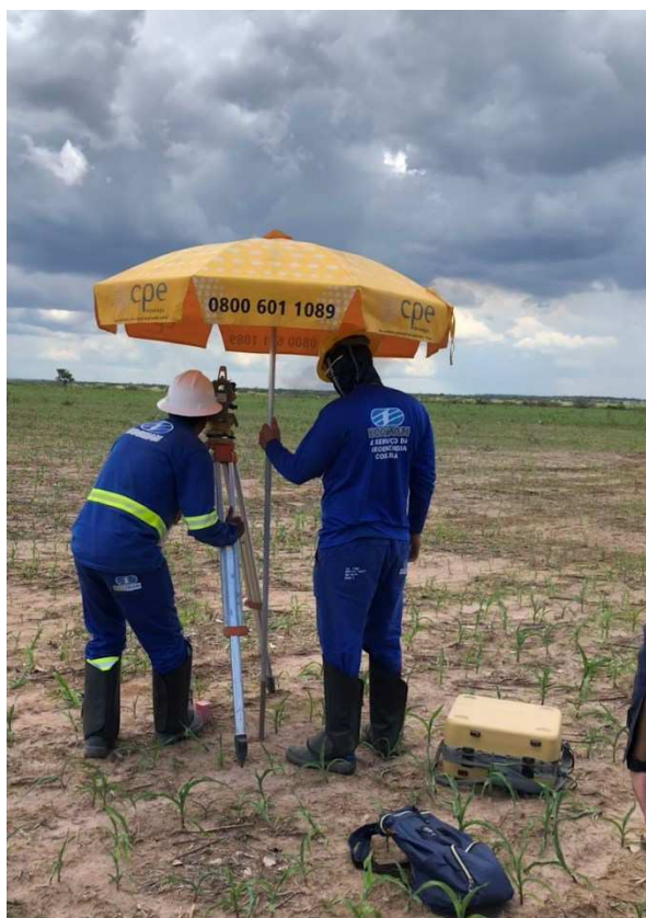
Figura 12 – Primeiro acompanhamento de locação de estrutura.
