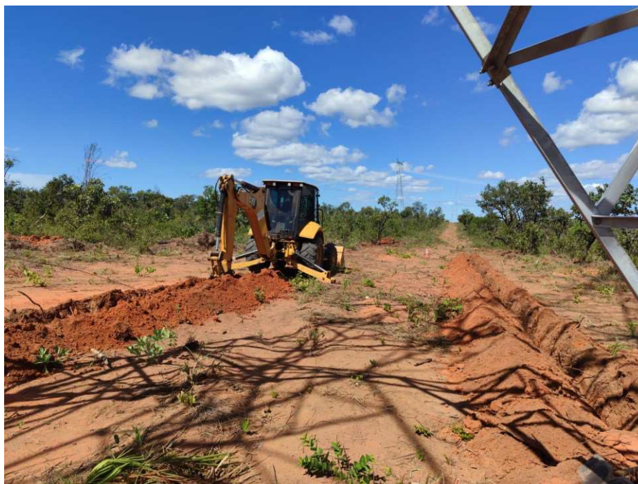
Figura 25 – Instalação do sistema de aterramento.
