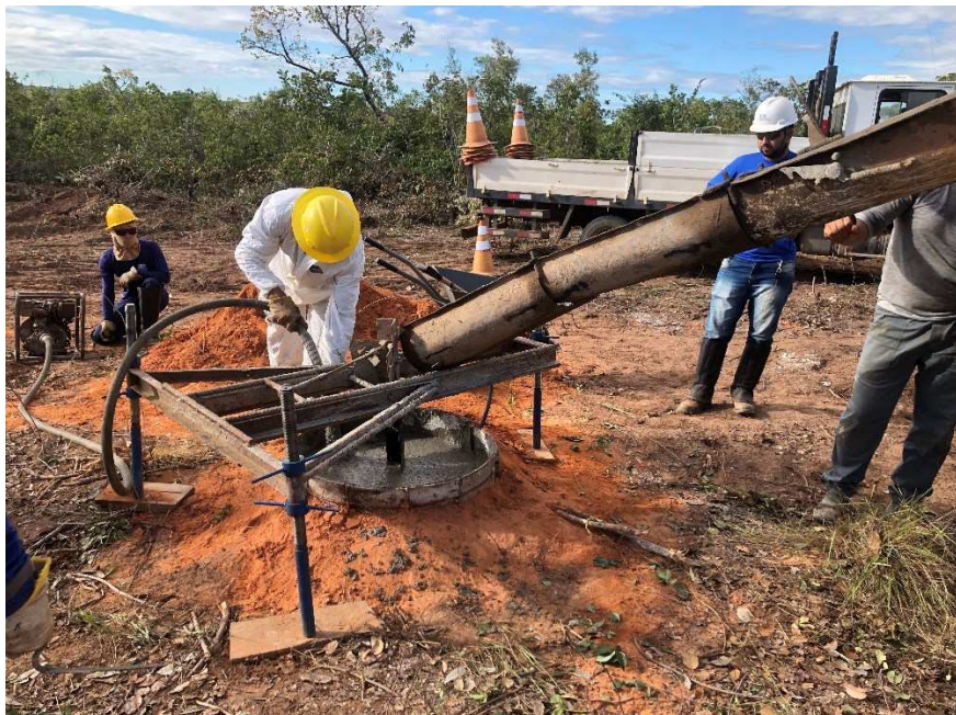
Figura 20 – Concretagem de tubulão.
