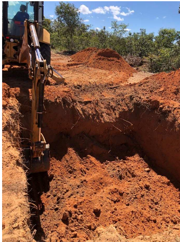
Figura 14 – Processo de escavação das sapatas.
