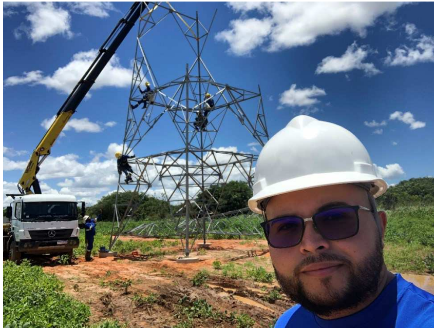
Figura 27 – Acompanhamento de içamento de pé e extensão.
