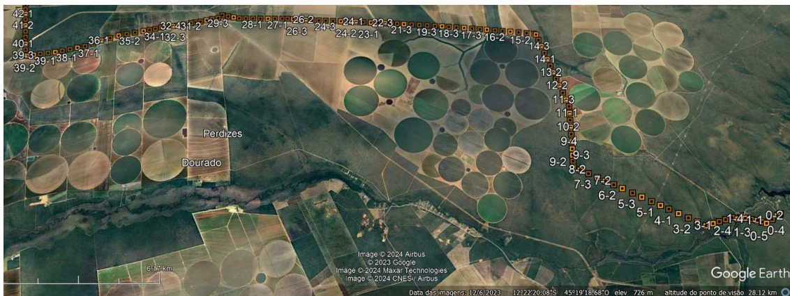
Figura 1 – Visão aérea da obra.
