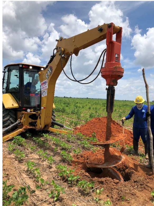
Figura 13 – Processo de escavação dos tubulões.
