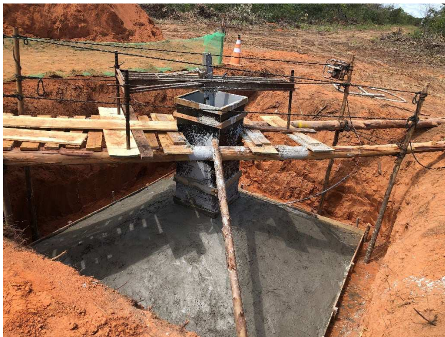
Figura 21 – Concretagem de sapata.
