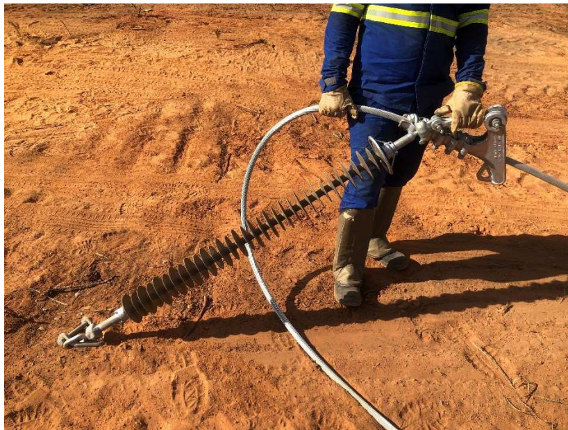
Figura 32 – Isolador preparado para instalação.
