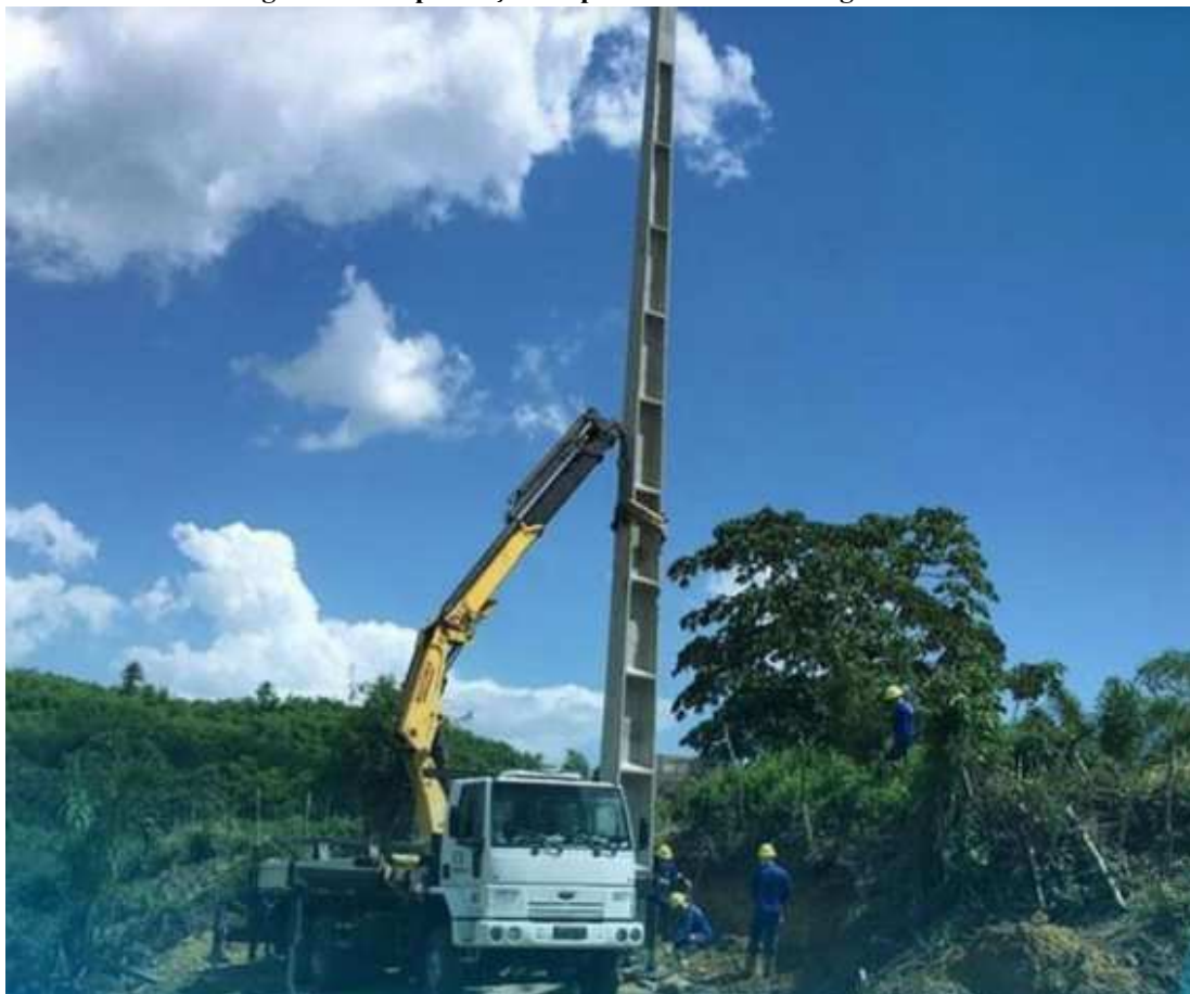
Figura 10: Implantação do poste com auxílio do guindauto.
