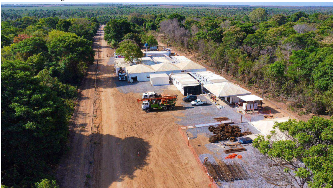
Figura 3: Canteiro de obras de uma linha de transmissão de 138 kV.
