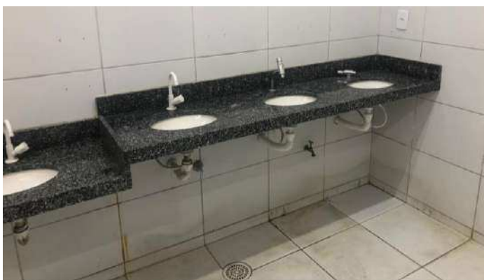
Figura 70 - Lavatórios do sanitário feminino Fonte: Grace Santos 2023.
