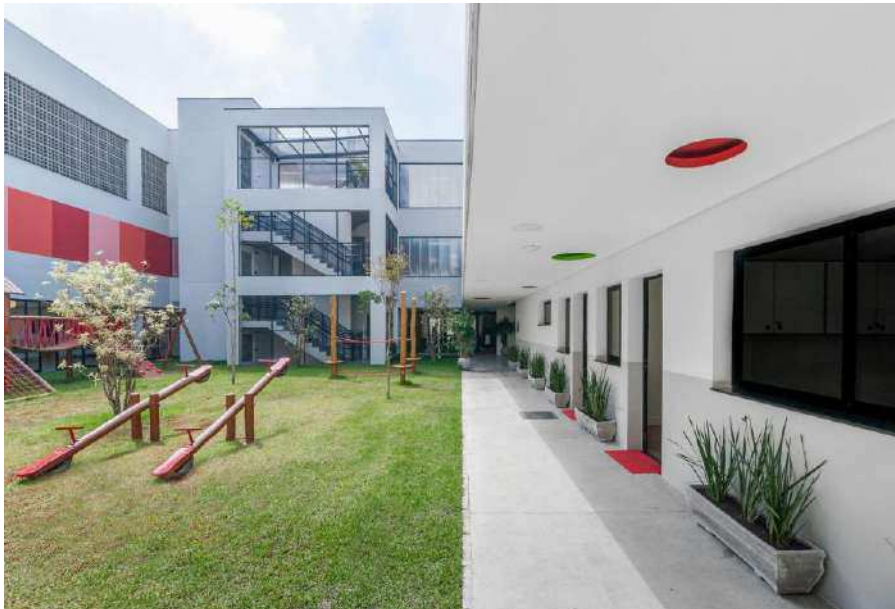
Figura 34 - Pátio interno aberto
