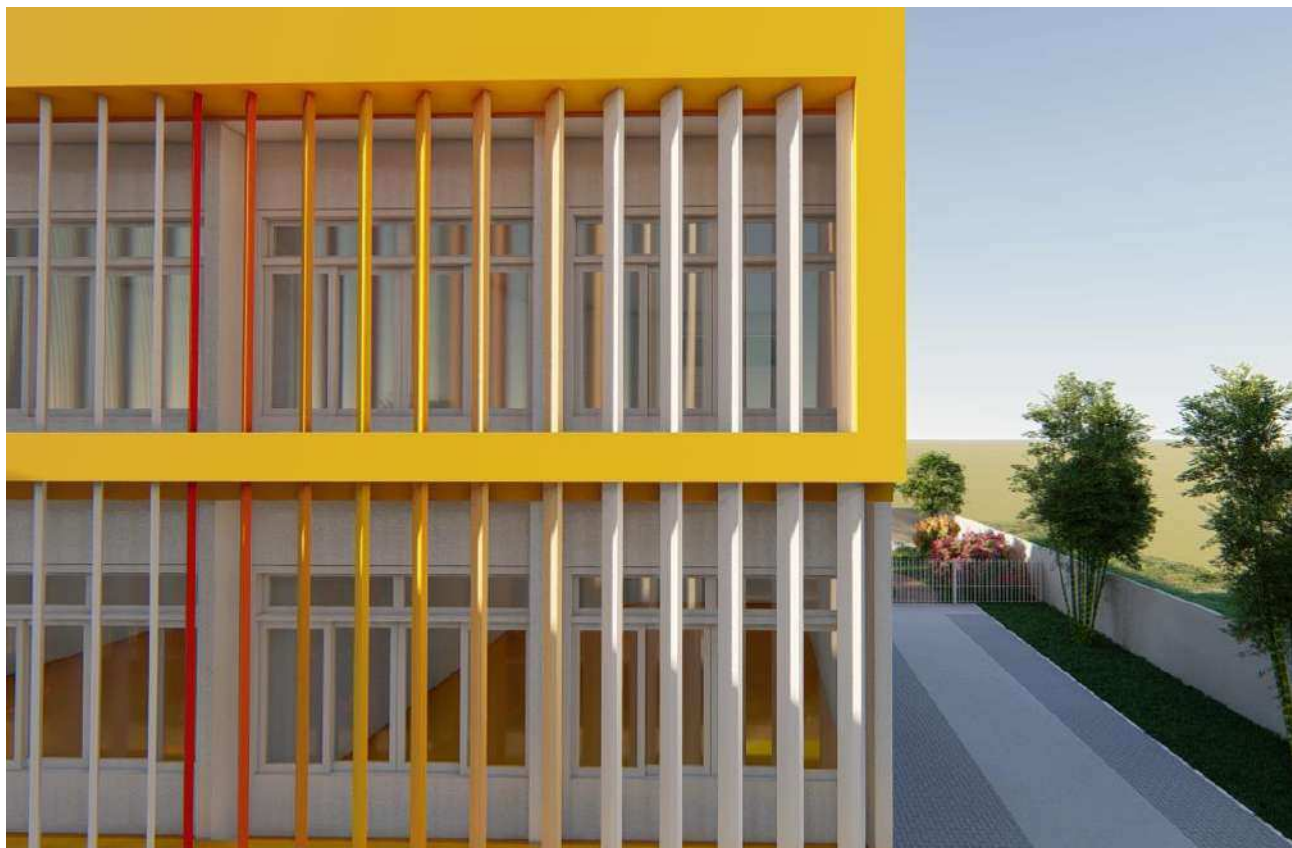
Figura 90 - Grandes esquadrias para a iluminação e ventilação natural protegidas por brises
