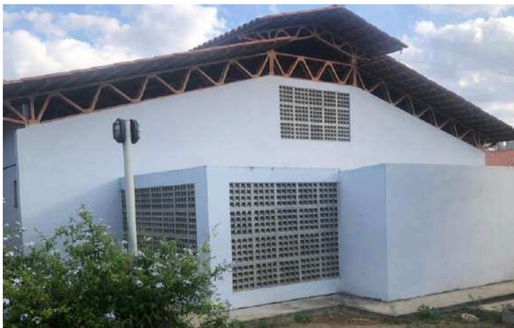
Figura 68 - Área de serviço e coradouro isolados. Fonte: Grace Santos 2023.
