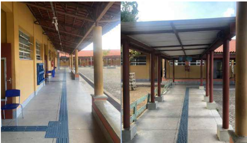
Figura 64 - Imagens da circulação interna Fonte: Grace Santos 2023.
