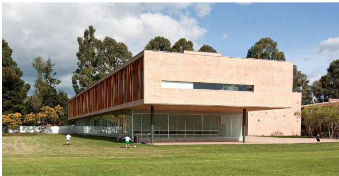
Figura 7 - Fotografia da área externa da edificação
