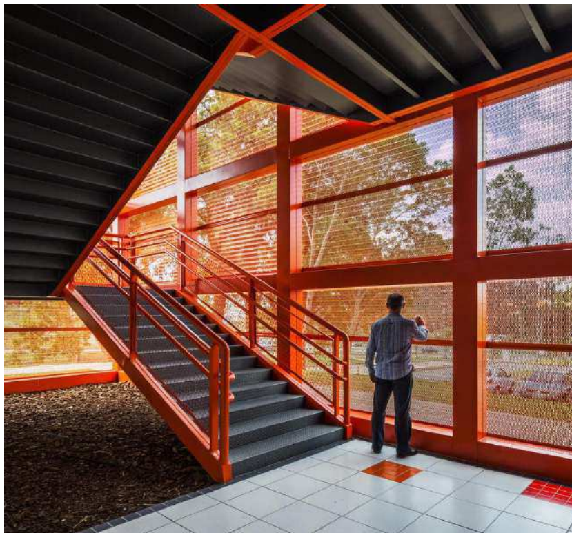
Figura 25 - Escadaria vedada por painéis metálicos perfurados
