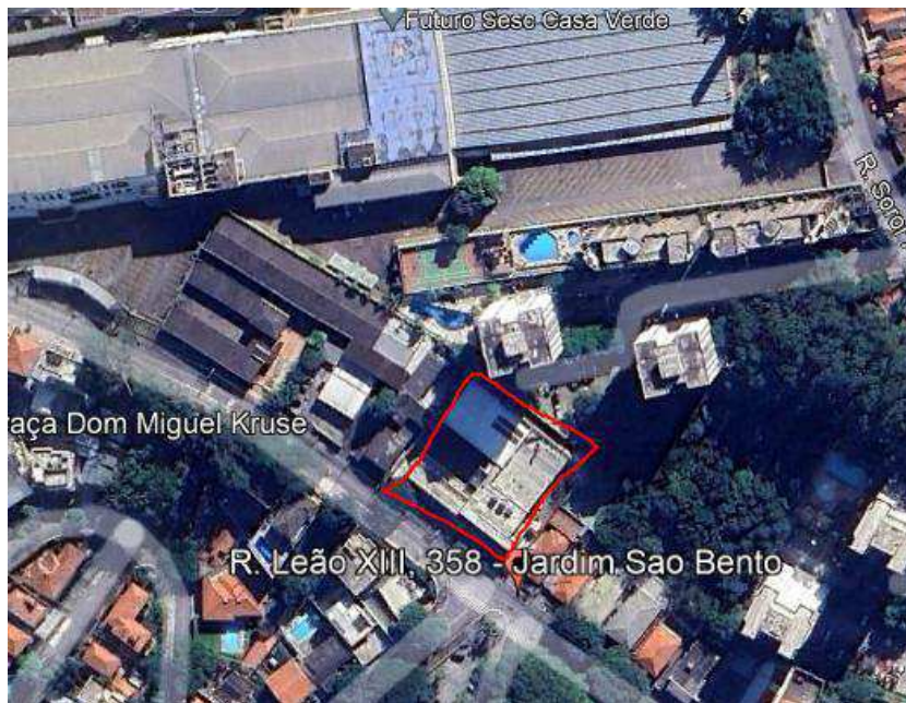
Figura 27 - Imagem área da construção
