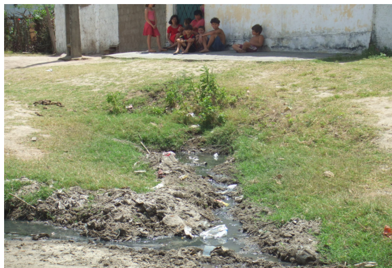
Figura 16. Esgotos a céu aberto
