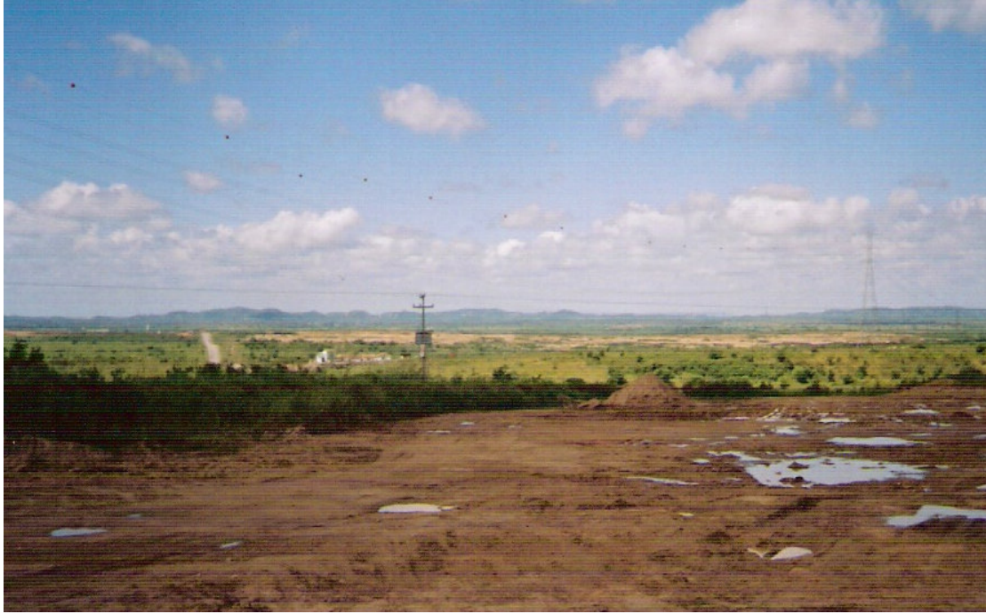
Figura 7. Área de retirada de material (solo exposto)
