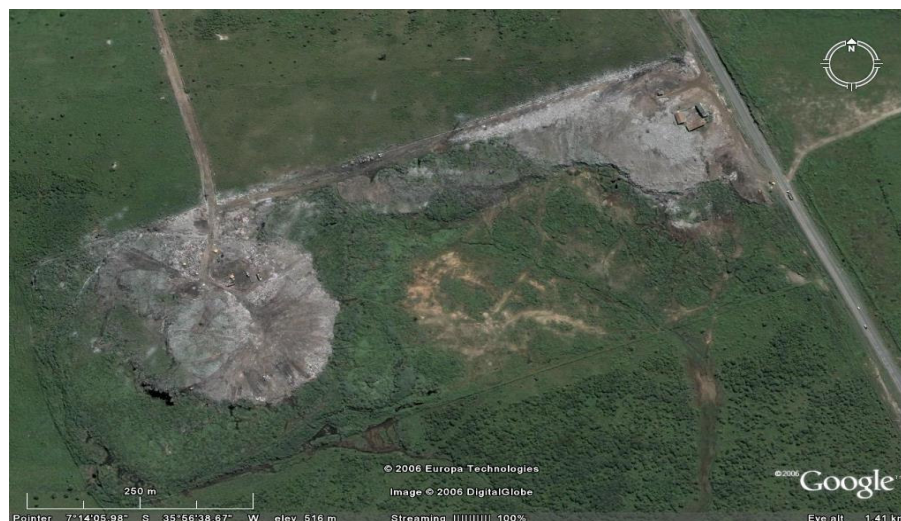
Figura 20. Vista superior do lixão (Fonte: Imagem 2006, Digital Globe)
