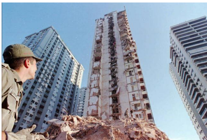
Figura 2 - Desabamento Parcial do Edifício Palace II, Rio de Janeiro, 1998.
