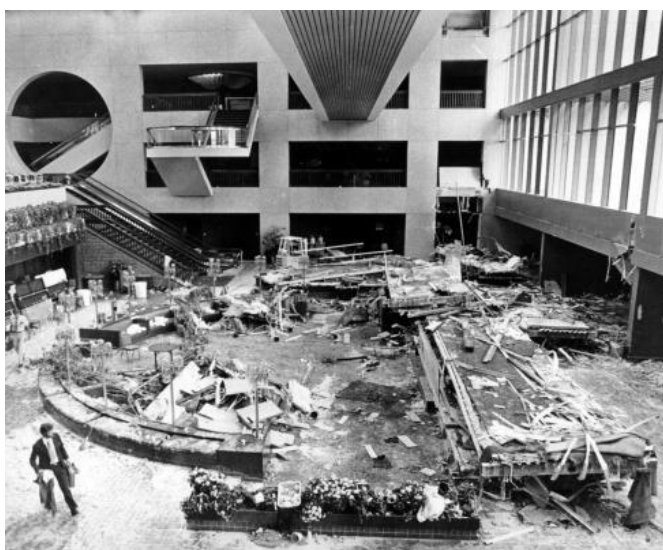
Figura 1 - Colapso da passarela de Regency Skywalk, em 1981 (Kansas City, EUA).
