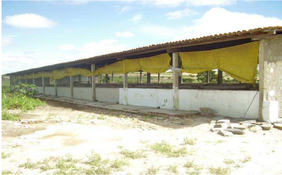
Figura 2. Vista lateral do galpão de maternidade
