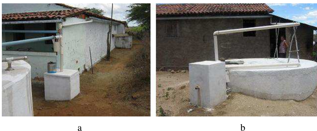
Figura 61. Sistema de desvio automático das primeiras águas. a) DFH-SJC4; b) DVC-PB4
