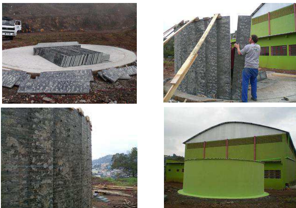
Figura 14. Etapas da construção de cisternas de ardósia armada
