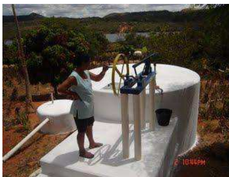
Figura 19. Bomba d'água aro trampolim.
