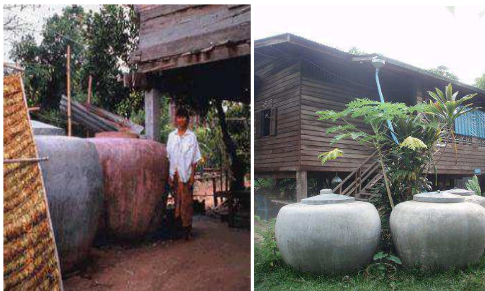
Figura 4. Tipos de jarras usadas no armazenamento da água da chuva na Tailândia.
