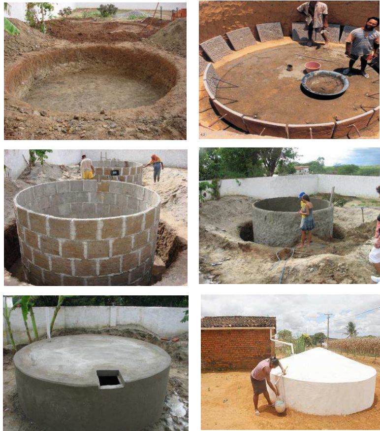
Figura 13. Etapas da construção de cisternas de placas pré-moldadas
