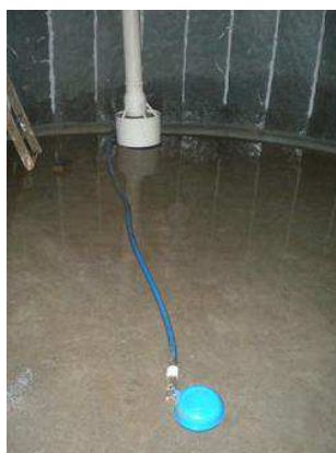
Figura 18. Ponto de captação da água da cisterna na superfície
