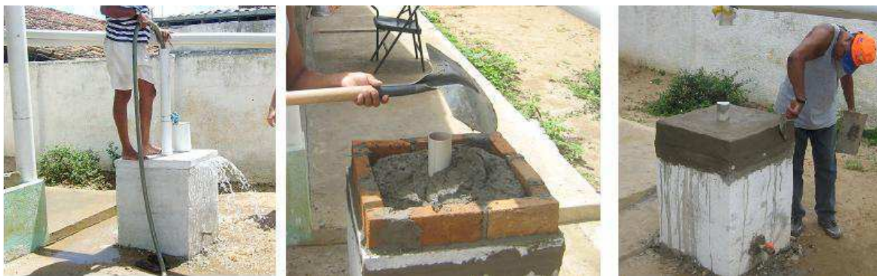
Figura 27. Experimento de vazamento e reparo nos desvios com princípio de fecho hídrico
