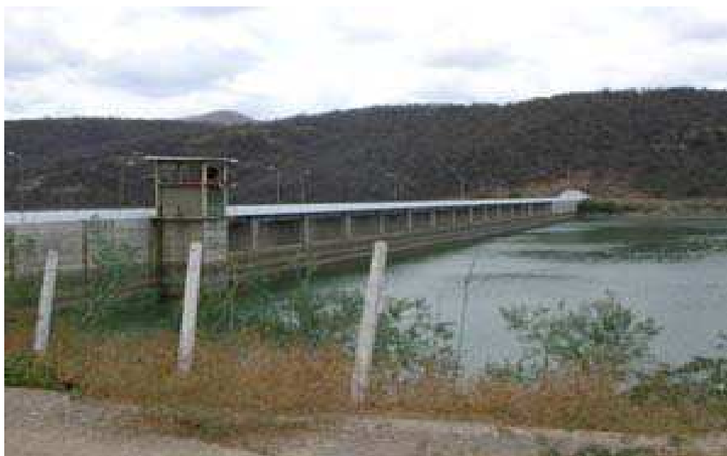
Figura 4.6 – Vista a Montante do Reservatório Acauã
