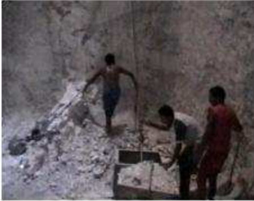
Foto 16 Trabalhadores enchendo a concha
