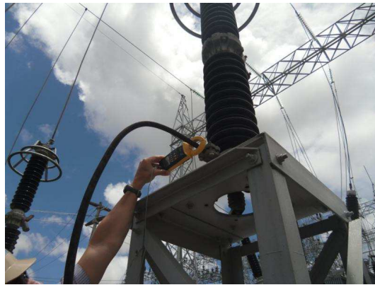
Figura 5.7 - Ilustração de medição da corrente de fuga total em campo.
