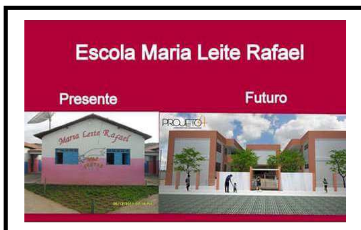
Figura 04 – Fachada da Escola Municipal do Bairro Alto Alegre
