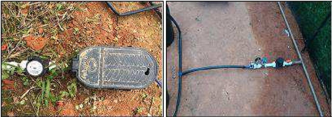
**Figura 16.** Conjunto com válvula solenóide, manômetro, registro de gaveta e hidrômetro, montado na entrada de cada bloco.
