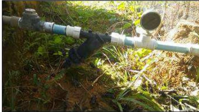
**Figura 12.** Cabeçal de controle com filtro de disco de 1”, manômetro de glicerina e válvula de retenção.
