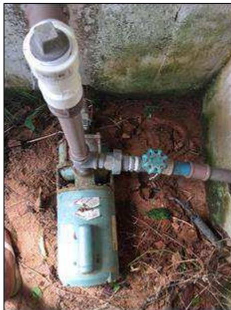
Figura 11. Conjunto Motobomba de 1,0 cv, modelo P11/3
