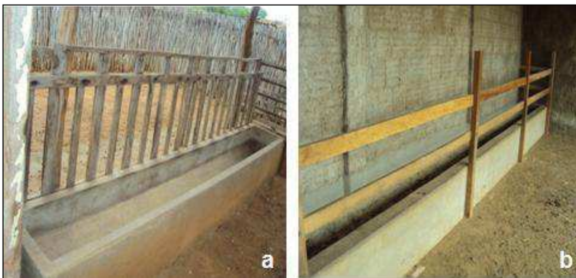
Figuras 6. Comedouro de alvenaria com canzil inglês (a) e comedouro de alvenaria com canzil livre (b). Fonte: Acervo pessoal.
