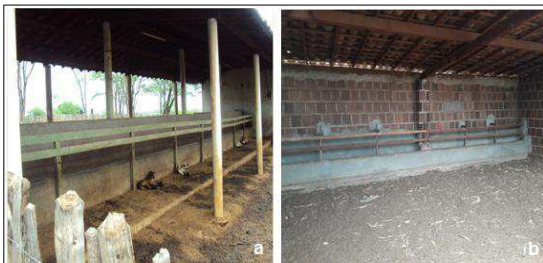
Figuras 8. Comedouros em alvenaria construídos sob a cobertura das instalações. Fonte: Acervo pessoal.
