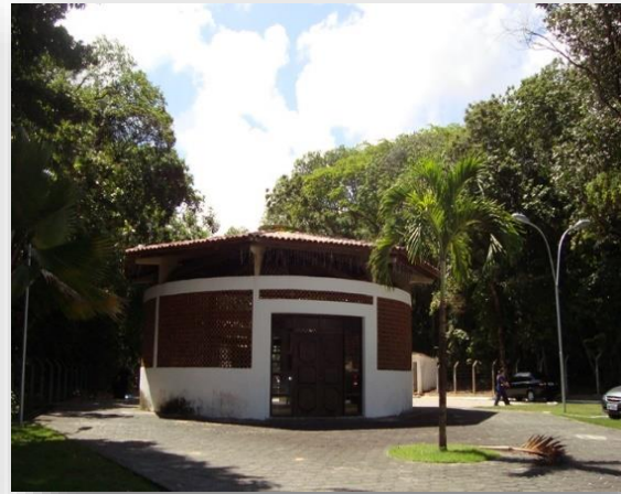
Foto 02: Capela da UFPB, campus I João Pessoa .
