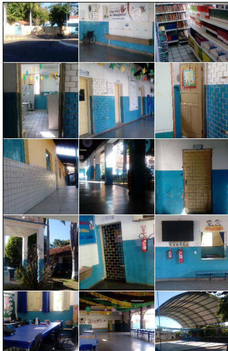
Figura 02 a 16. Estrutura Física da Escola Dom Moisés Coelho.
