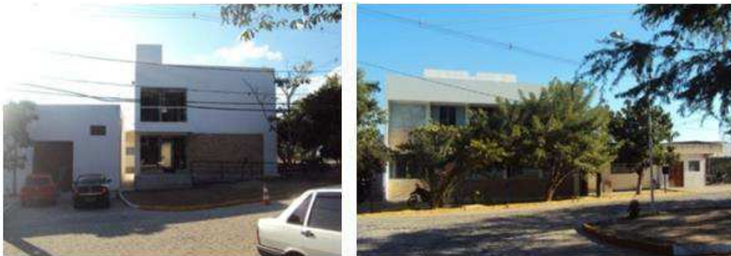
Figura 3.1 – Laboratório experimental de máquinas térmicas, UFCG.
