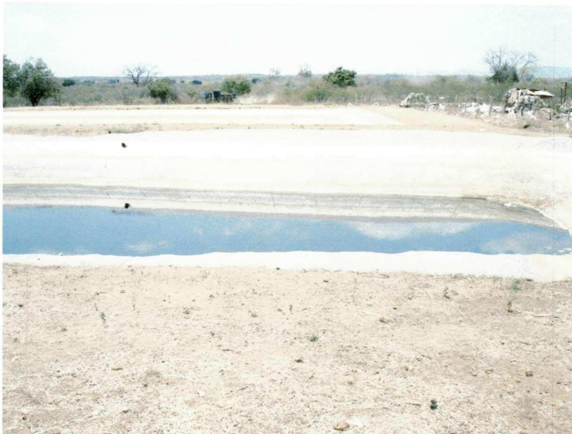
Foto 3: Lagoa de Tratamento – Aterro de Cajazeiras-PB. Fonte: Liliane Pineiro de Sousa.
