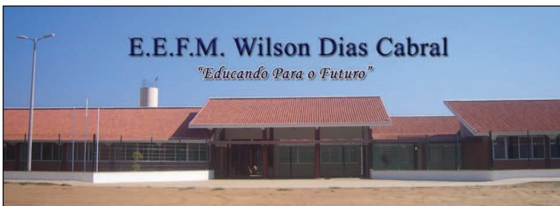
Imagem 01: Fachada da Escola
