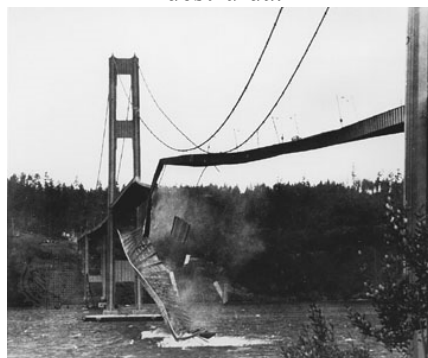
Figura 2.2 – Ponte Tacoma Narrows destruída.
