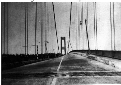
Figura 2.1 – Ponte Tacoma Narrows com grandes deformações.
