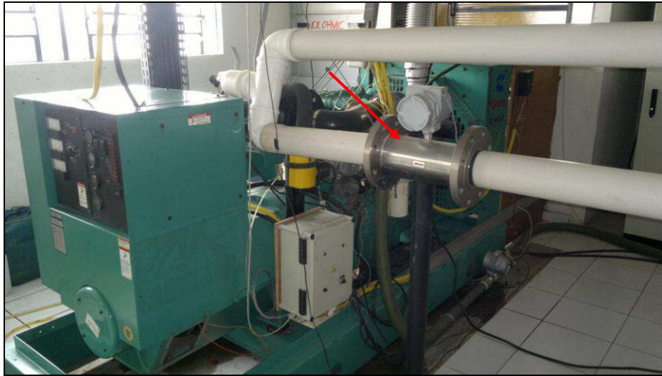
Figura 3.16 – Medidor de vazão de ar – Tipo turbina
