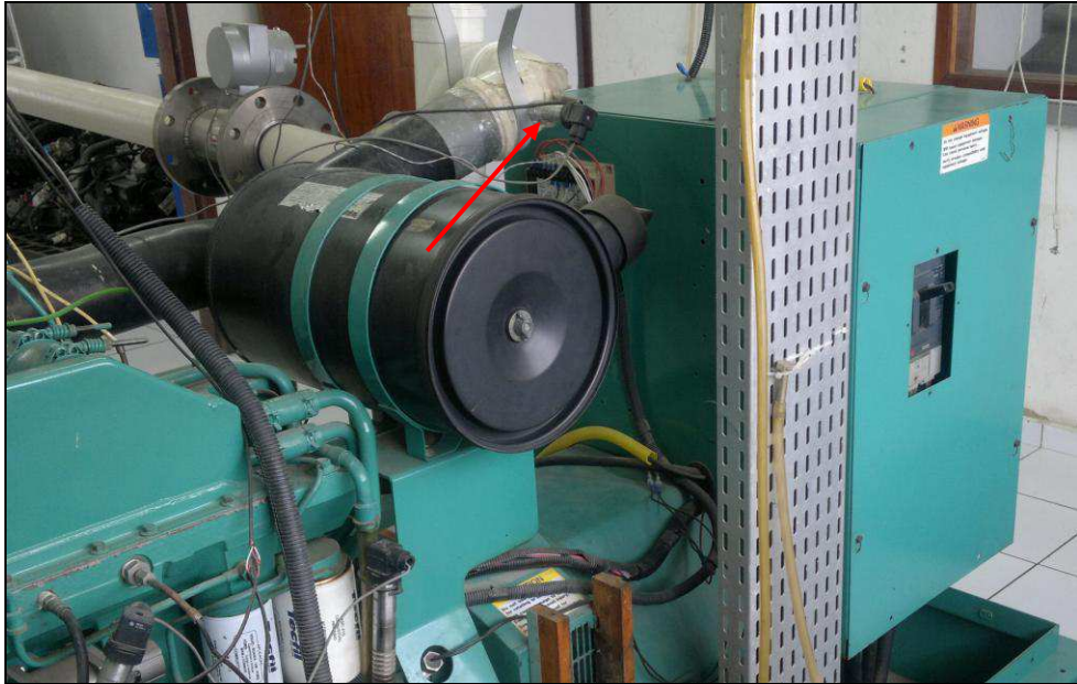
Figura 3.7 – Sensor de medição de pressão e temperatura do ar na entrada do motor
