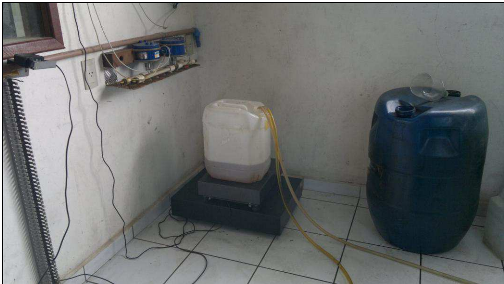
Figura 3.5a – Sistema de pesagem do combustível diesel/biodiesel
