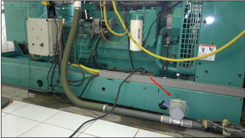
Figura 3.17 – Medidor de vazão de gás – Tipo turbina
