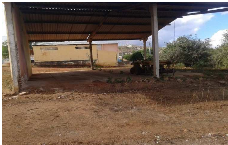
Foto 56: Galpão da garagem do DNOCS
