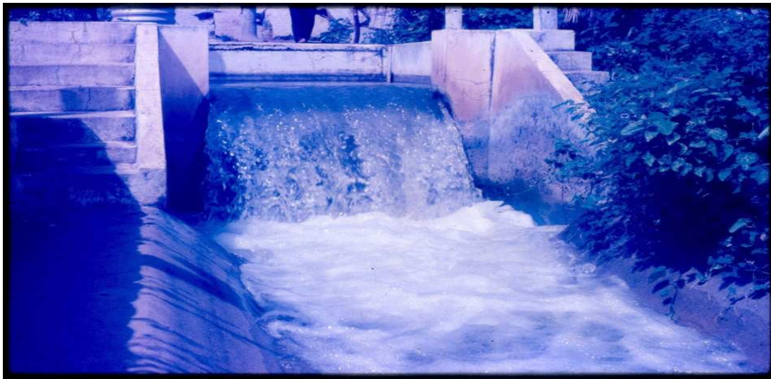
Foto 3: Abertura da Comporta do Açude para o canal principal do PIS.
