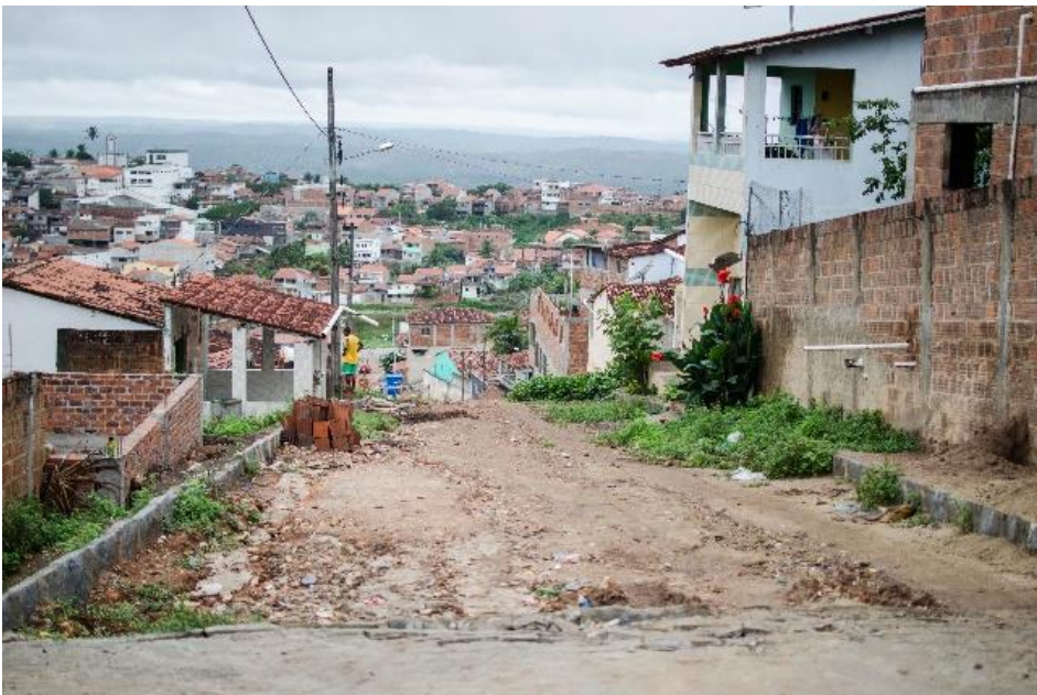
Figura 6 - Ruas sem infraestrutura. Fonte: Autor
