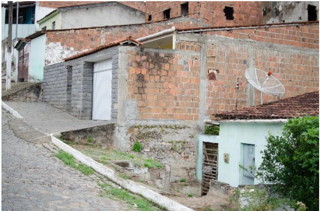
Figura 3- Inexistência de calçadas. Fonte: Autor
