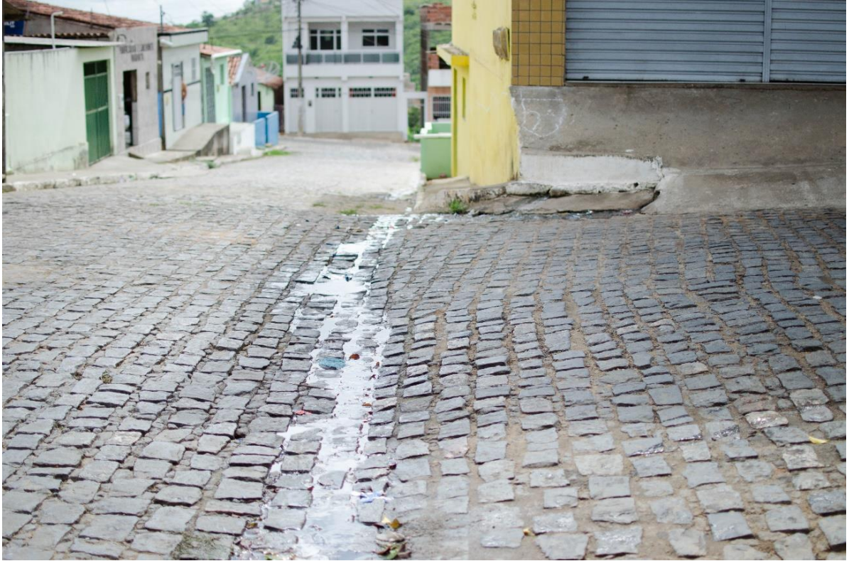
Figura 14 - Esgoto pelas ruas. Fonte: Autor
