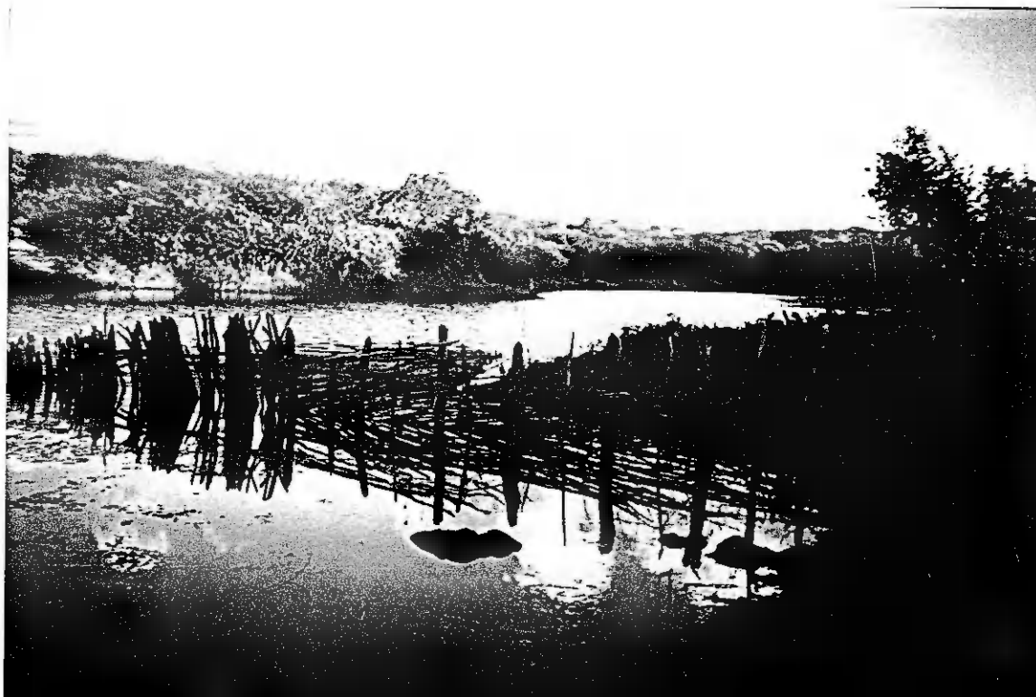
Foto nº A.2 - Açude Carimbembe.
