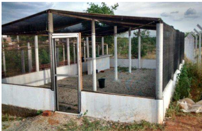
Figura 1. Vista geral do ambiente protegido
