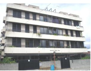
ANEXO 05 – Edifício com alvenaria estrutural
