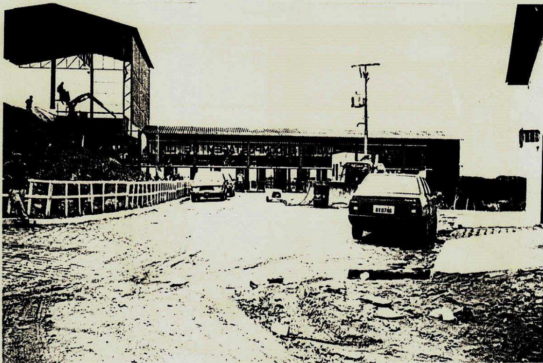
FIGURA I.1 - Vista geral da usina de reciclagem e compostagem de lixo urbano da cidade de Natal. Estado do Rio Grande do Norte.
