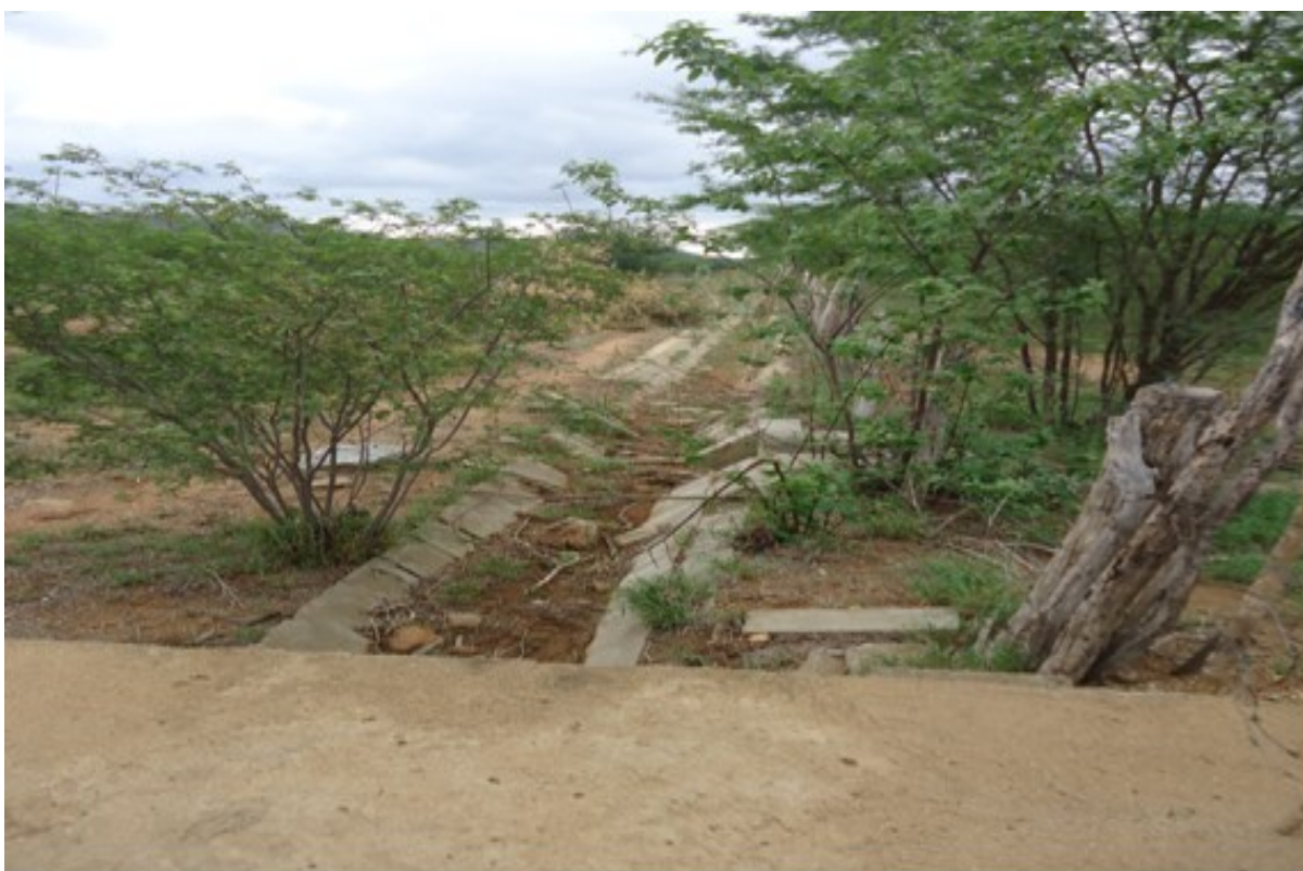
FOTO 01: Trecho do canal de irrigação semi aterrado
