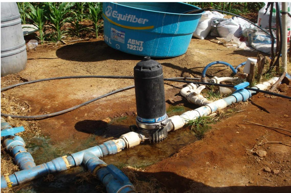
LOTE 17 - SISTEMA DE IRRIGAÇÃO POR GOTEJAMENTO COM FERTIRRIGAÇÃO ACOPLADO-
