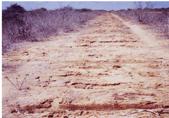
Figura 17 – Marcas no solo dos dormentes retirados da ferrovia Sousa-Mossoró (2002).
