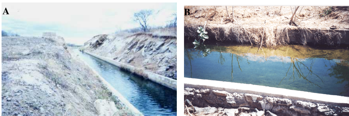
Figura 14 – Trecho em canal do Sistema Adutor das Várzeas de Sousa.
