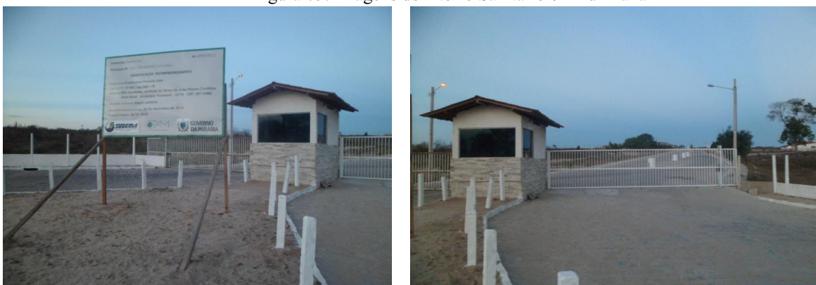
Figura 05: Imagens do Aterro Sanitário em Puxinanã
