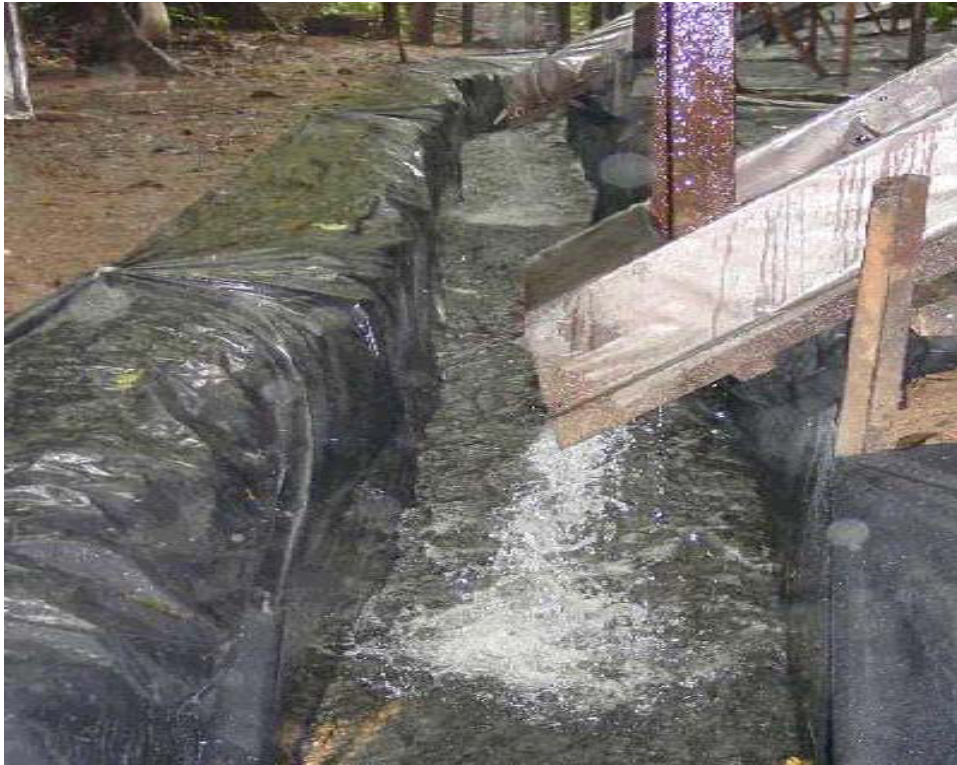
Figura 4. Detalhe da trincheira para drenagem da chuva na parcela B no experimento ESECAFLOR
