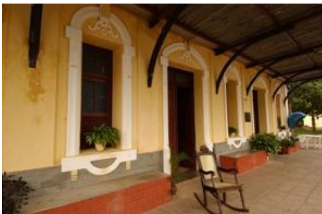
Foto 4: Estação de trem em Bananeiras.
