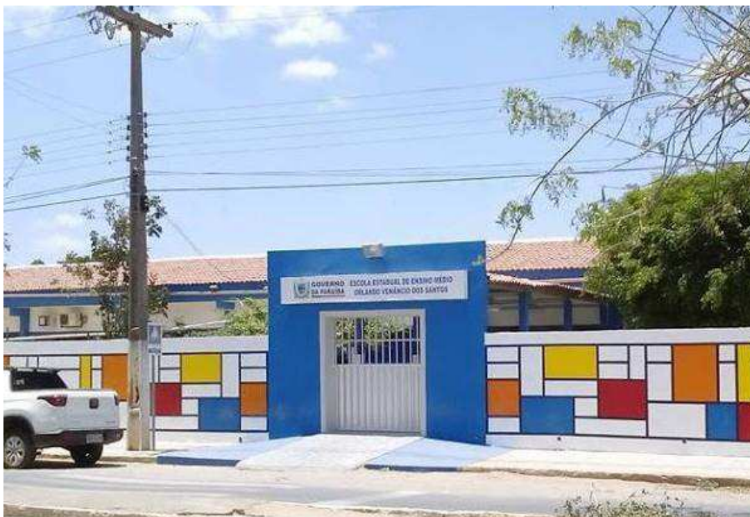
Figura 1. Fachada da Escola Cidadã Integral Orlando Venâncio dos Santos
