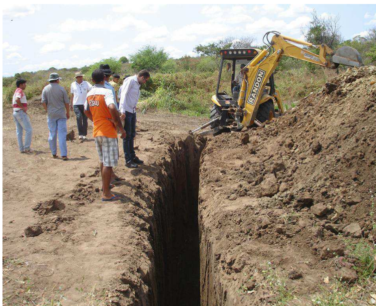
Fotografia 7: Abertura da vala. Sítio Sanharão, Encanto-RN, 2014.
