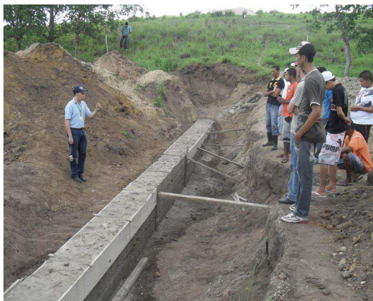
Fotografia 6: Barragem submersível Serra Negra do Norte. Serra Negra do Norte – RN, 2014.
