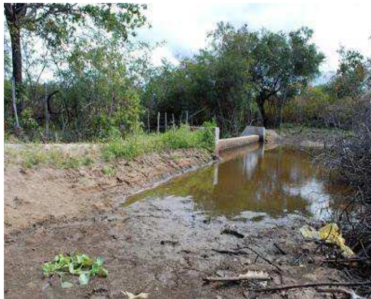
Fotografia 5: Barragem Submersível ASA Brasil. Sítio Verrume, Janduís – RN, 2014.
