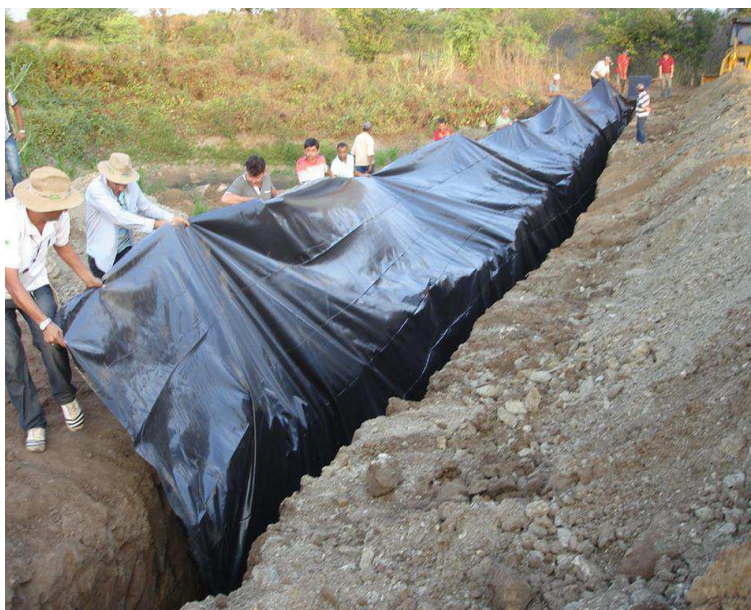
Fotografia 8: Colocação da lona. Sítio Sanharão, Encanto-RN, 2014.
