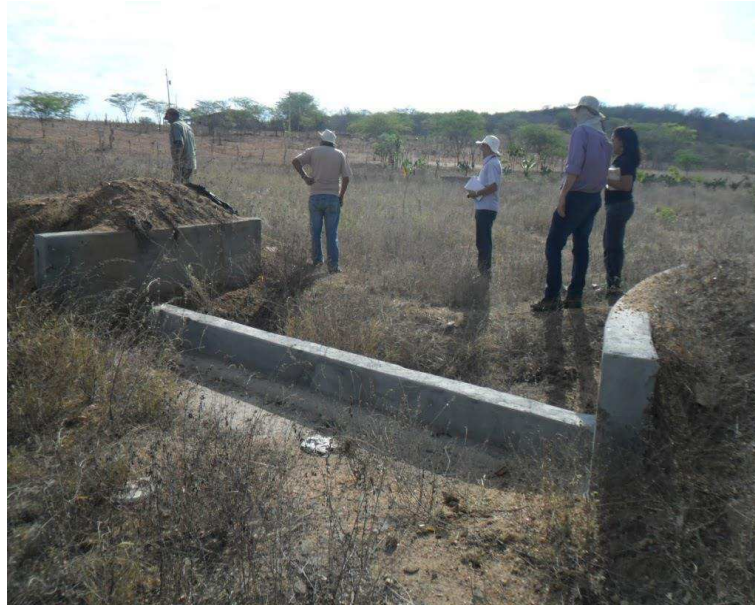
Fotografia 4: Barragem submersível EMBRAPA. Assentamento Pedra D'agua, Buíque – PE.
