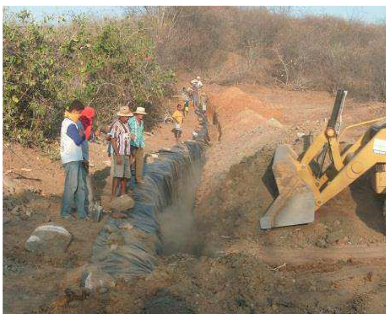
Fotografia 9: Fechamento da vala. Sítio Riachão dos Jocas, Venha Ver-RN, 2014.
