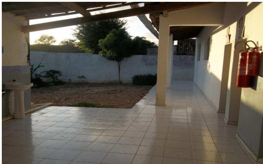
Foto 04- Pátio escolar e Banheiros Fonte: arquivo pessoal da autora (2017)
