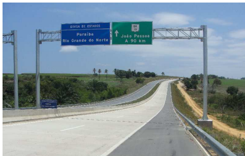
(a) Rodovia BR-101 entre PB e RN.
